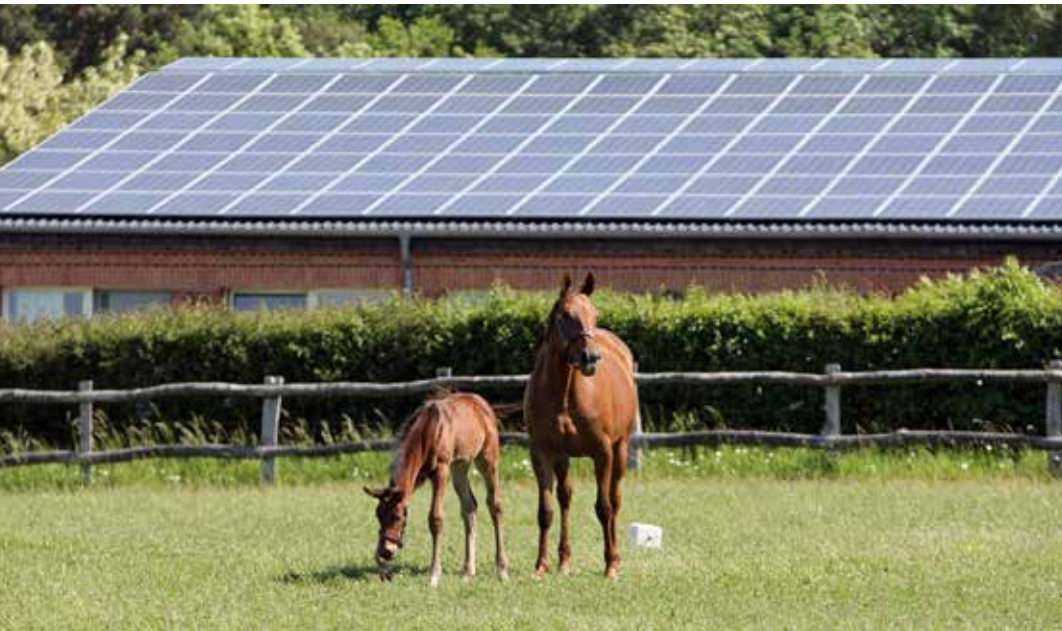
Eine Photovoltaik-Anlage verursacht zunächst hohe Anschaffungskosten, diese können sich jedoch amortisieren. Foto: Frank Sorge
